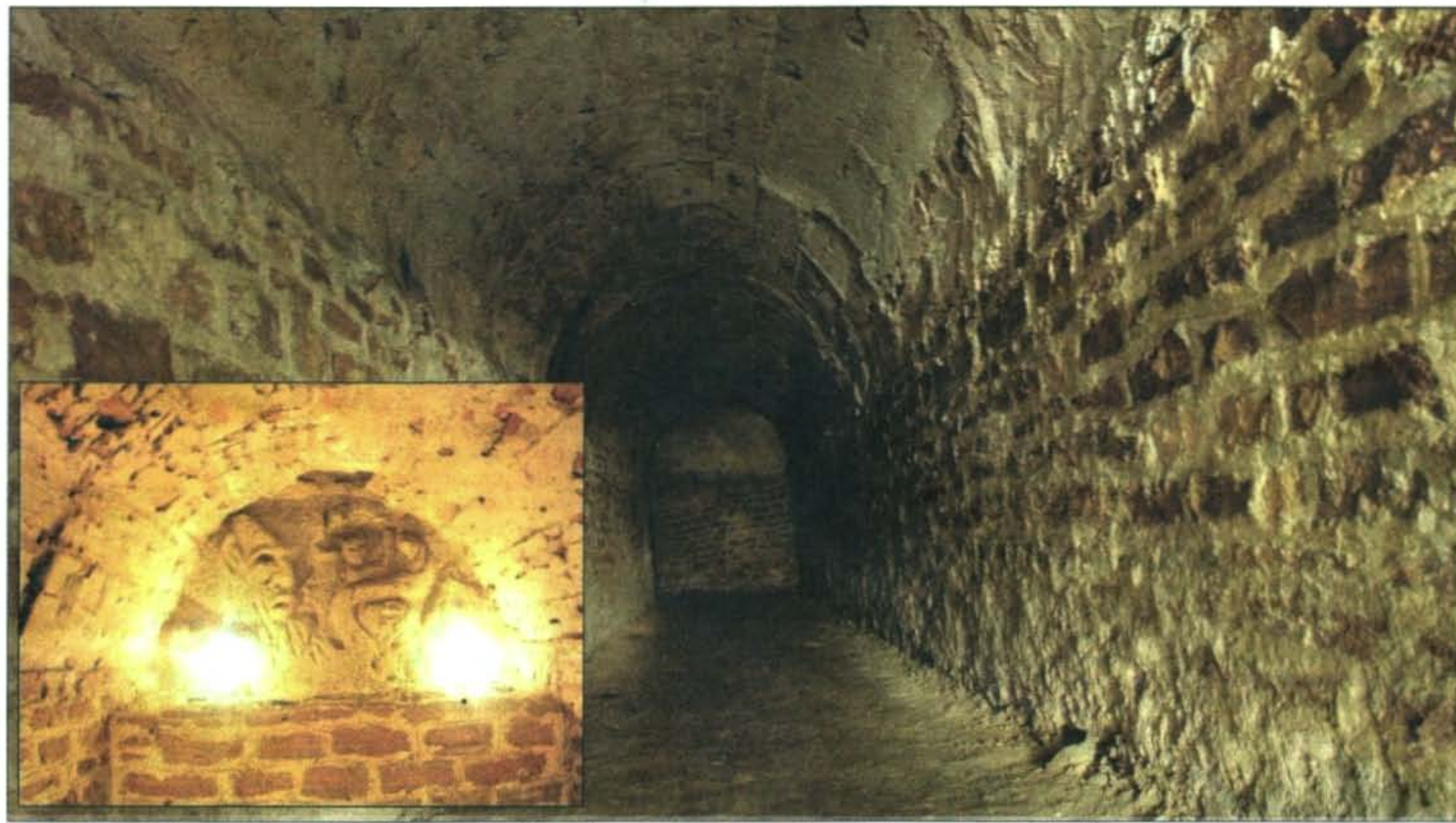
Depuis février 1989, un arrêté municipal régleme l'accès au réseau souterrain lyonnais : seuls les personnels de la ville assermentés y sont admis. Serrures et cadenas ont été installés sur la plupart des accès recensés. Les cataphiles y sont tolérés d'autant qu'ils s'y investissent
